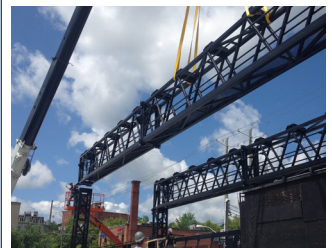
Installation des poutres
