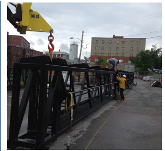
Une des poutres au sol
