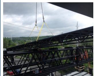
Installation des sections de toit
