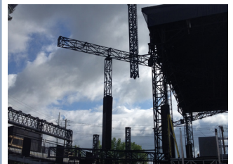
Installation des colonnes
